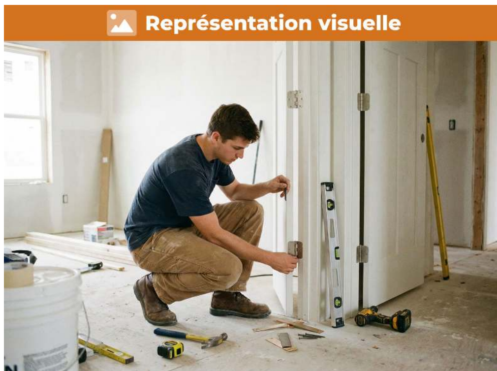
Ajustement de la charnière pour un jeu latéral uniforme de 2 à 4 mm sur la porte
